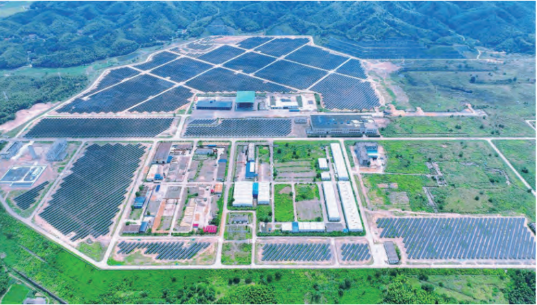
汇荷光伏发电项目俯瞰图
