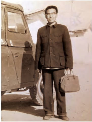
王锦奎在建筑工地
