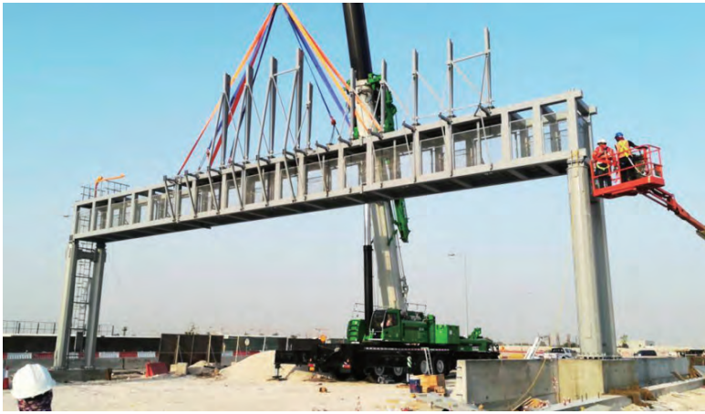
在卡塔尔现场安装钢结构
